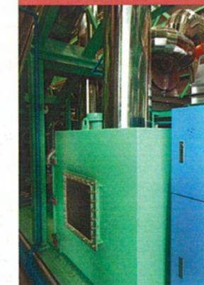
原料に含まれている分解されない無機物や金属片などの異物は、熱分解対象物と分離され、傾斜管の最上部からスクリーフフィーダーにより連続的に装置から排出され、自動的に残渣タンクへと集められます。
